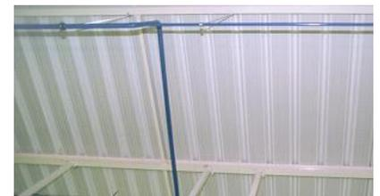
Exemple de couverture thermo-acoustique avec bac métallique perforé et coefficients d'absorption sonore fournis par le fabricant
