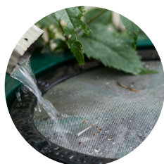
Système de récupération d'eau de pluie
